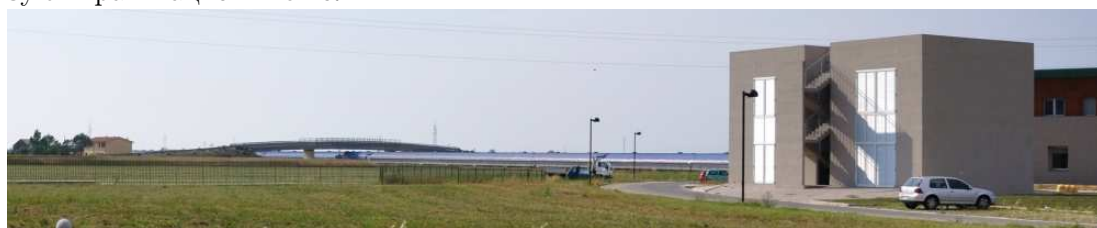
Рис. 1.3: Гравитационный телескоп (интерферометр Майкельсона, длина плеча=3км) VIRGO в Италии — вид на западную трубу от ворот комплекса. [Иван Сивцов. W]
